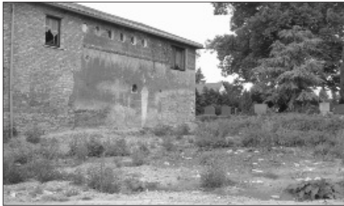
Grundstück vor der Baumaßnahme
