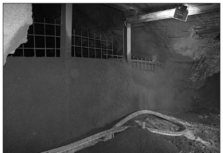
Dammerrichtung in mehreren Arbeitsschritten
