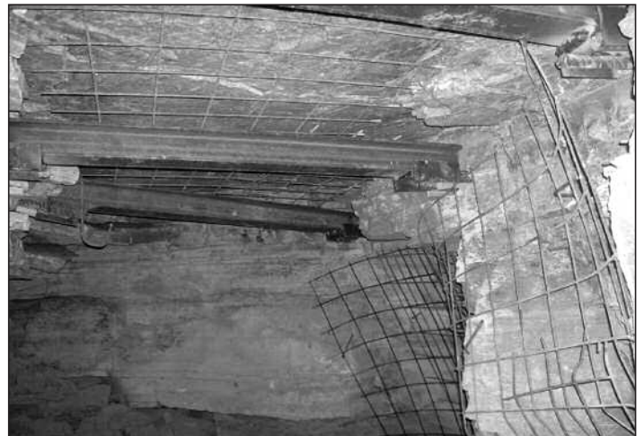
Sicherungsmaßnahmen unter Tage und Vorbereitung zur Verfüllung
