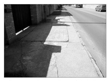
Auf Grund stark sanierungsbedürftiger Oberflächenbereiche, einiger intensiver Setzungserscheinungen im Gehwegbereich durch defekte Regenwasserkanäle sowie der sowohl sehr umfänglich vorhandenen, zerbröckelten bzw. fast überhaupt nicht mehr existenten Hochborde, als auch die geplanten Abrüst- und Erneuerungsarbeiten seitens der genannten Rechtsträger, bestand die Notwendigkeit zur Realisierung dieser Baumaßnahme.
